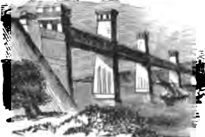
Britannia Tubular Bridge.
